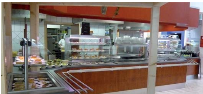
La vitrine self-service, un des postes froids alimentés par le groupe Copeland OMTQ 90D
